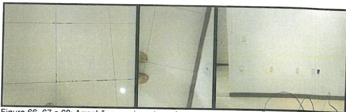
Figura 66 ,67 e 68: Arranhões no piso e tomadas sem capinha na sala conjugada.
