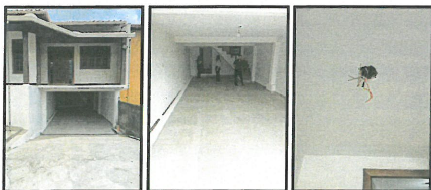
Figura 5, 6 e 7: Garagem, interior da garagem e observação para fiação exposta.
