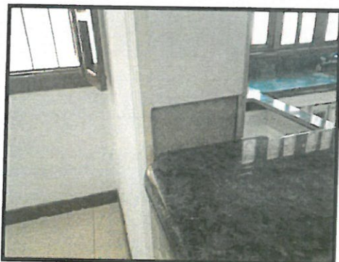
Figura 64: Azulejo faltando no balcão da cozinha.
